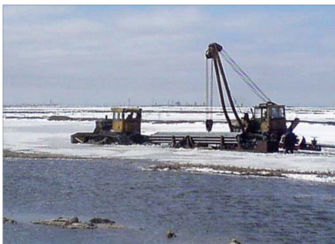
Рис. 2. Процесс монтажа трубопровода в условиях заболоченной местности в Западной Сибири
