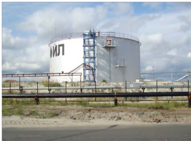
Рис. 3. Трасса трубопровода, смонтированного неразъемным муфтовым соединением
